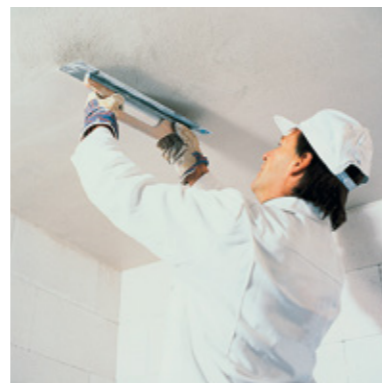
Putz aufziehen und glätten
