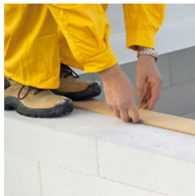
Im Auflagebereich werden Unterlagstreifen angebracht
