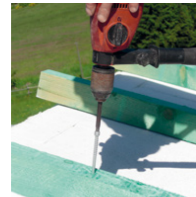
Holzkonstruktionen wie z.B. Sparren lassen sich einfach und rasch mit Schrauben befestigen.
