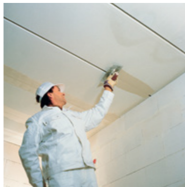
Glatte Untersicht: Füllen der Fugen
