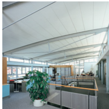
Helle Optik mit sichtbarem Fugenbild: Anstrich reicht aus
