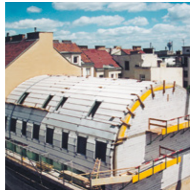
Dach: Mit Ytong lassen sich auch komplexe Formen realisieren.
