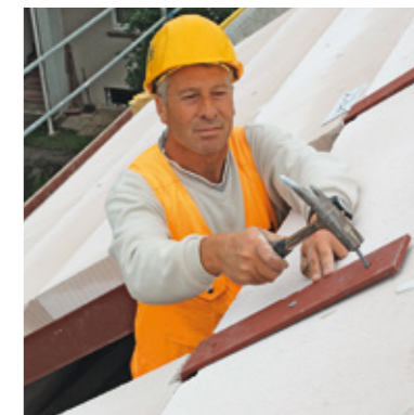
Einbau eines Stahlwechsellers
