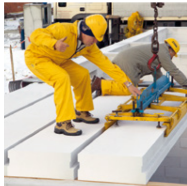
Die Elemente werden mit dem Kran verlegt.
