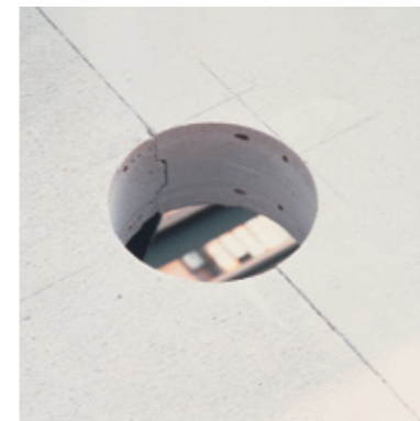
Baustellenseitig nachträglich hergestellte Öffnung
