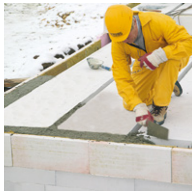
Die Fugen werden mit Vergussbeton aufgefüllt.
