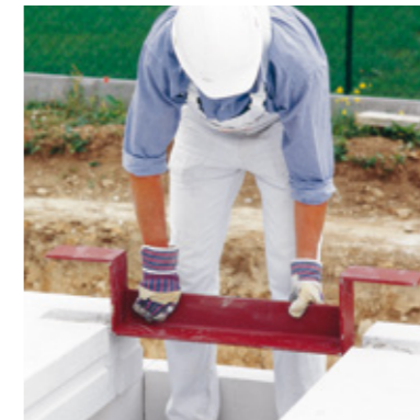
Einbau eines Stahlwechsellers
