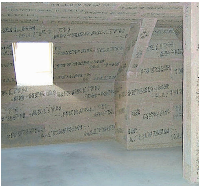
Dachkonstruktion beplankt mit Heraklith BM-Platten
