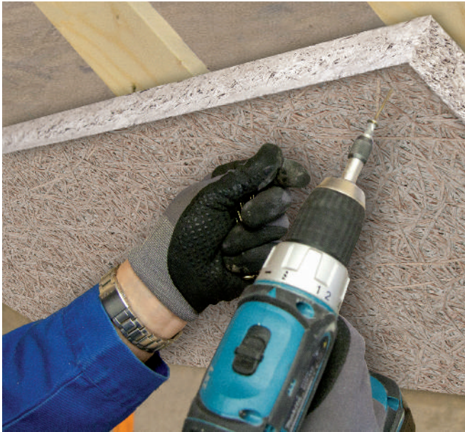
Befestigung der Heraklith BM-Platte (35 oder 50 mm) mit Heraklith Kompaktbauschrauben, Länge 60 bzw. 80 mm.
