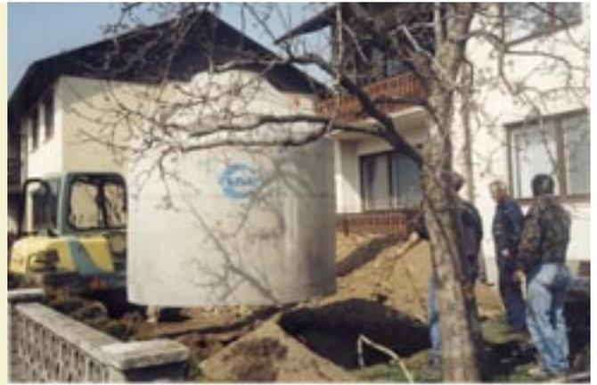
Vor der Sanierung, rechts: Einbau der Betonzisterne
