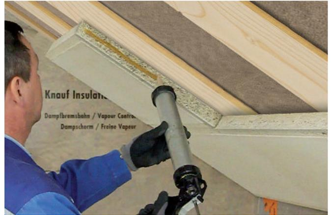
Kraftschlüssige Verklebung der Heraklith BM-W Platten mit Heraklith BM Kleber.
