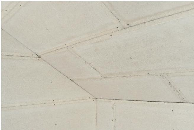
Die Platten werden im Verband versetzt und mit jeweils 9 Schrauben pro Platte montiert.
