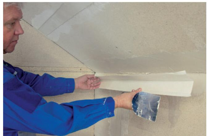
Einlegen des Übergangstreifens KNAUF Ultraflex zur exakten Kantenausbildung.
