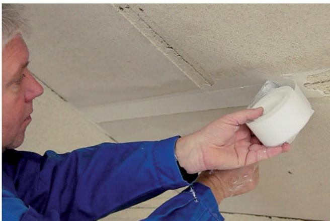
Einbetten des KNAUF Glasfaser Fugendeckstreifens.
