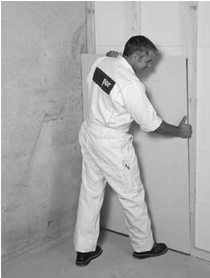
FERMACELL Gipsfaser-Platten auf Holzlatten als Trockenputz
