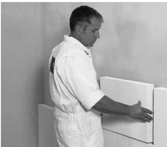
Einschwimmen der Multipor Mineraleddämmplatten im Kleberbett
