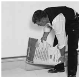
Fehlstellen mit Ausgleichschüttung auffüllen
