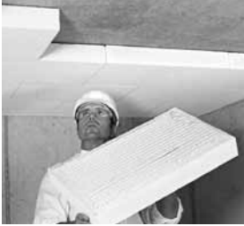
Vollflächige Verklebung der Platten bei der Deckendämmung
