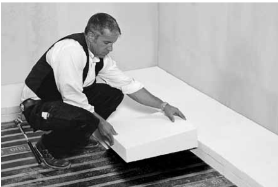
Flachdachdämmung mit Multipor Mineraldämmplatten in bituminösen Dachsystemen.
