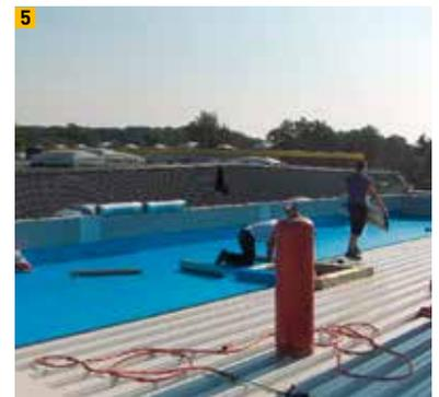
Dampfsperre aus Polyethylen
