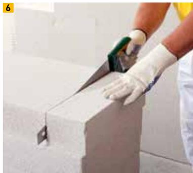
6 Zuschnitt der Multipor Steildachdämmung DAD
