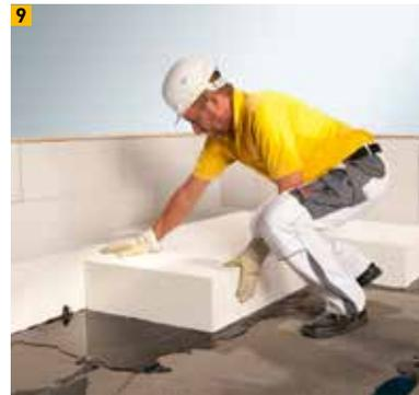
9 Dämmplattenverlegung in Heißbitumen
