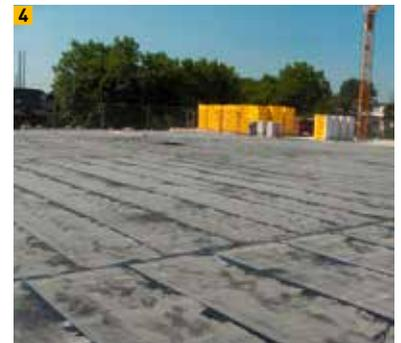
Dampfsperre mit Aluminiumeinlage, in Heißbitumen verlegt
