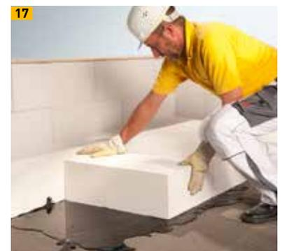
Dämmplattenverlegung in Heißbitumen
