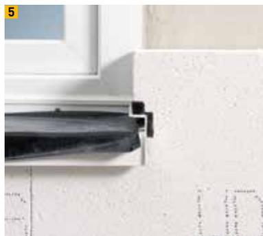
Bordprofil mit Fugendichtband
