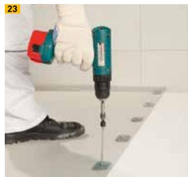
23 Kunststoffdachbahnen mechanisch befestigt
