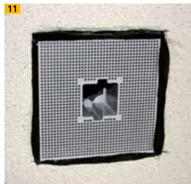
Eingebauter Multipor Geräteträger
