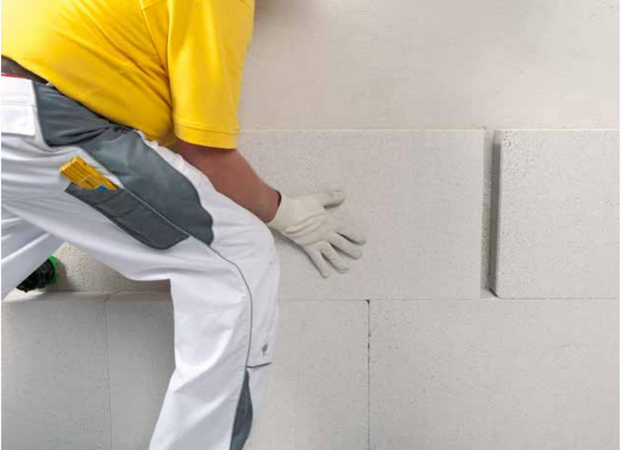
Abb. 6: Beispielhafter Wandaufbau mit Multipor Innendämmung
