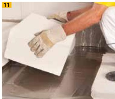
11 Dämmplattenverlegung in Flüssigdampfsperre
