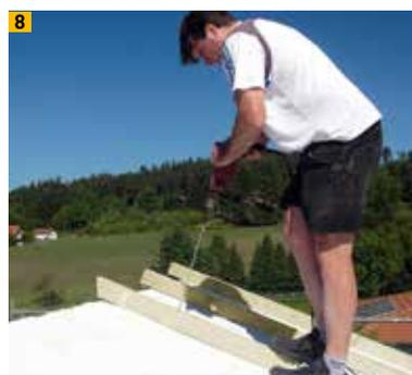
8 Einschrauben der Ytong Dachschraube auf dem Ytong Kombidach
