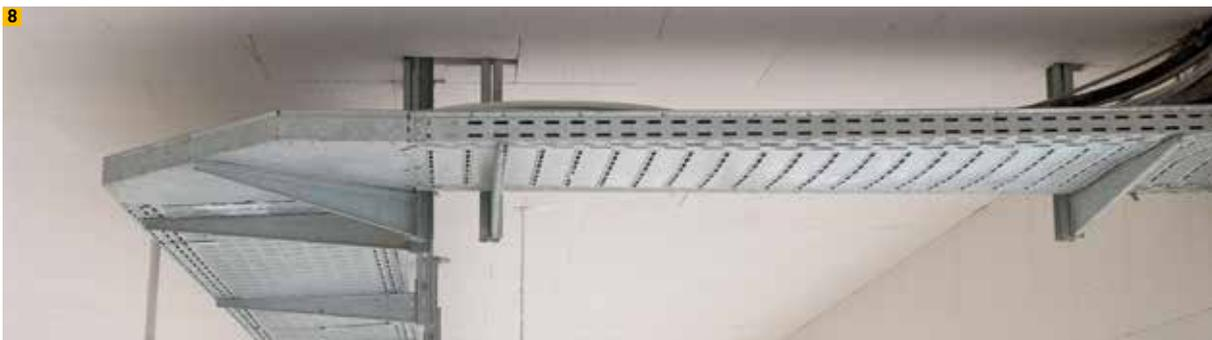
Befestigung eines Kabelträgers
