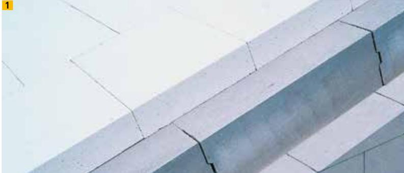
1 Multipor Mineraldämmplatte DAD auf gereinigter Fläche verklebt
