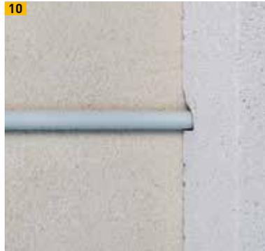
10 Platte ausklinken bei vorhandenen Elektroleitungen
