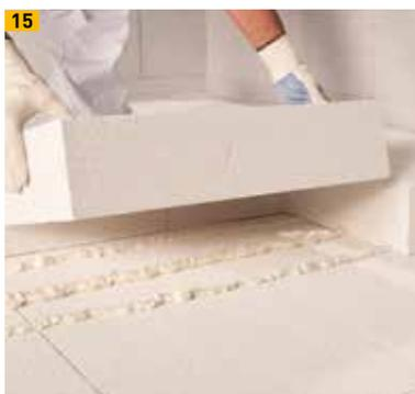
Dämmplattenverlegung mit PU-Kleber, hier als Montagefixierung
