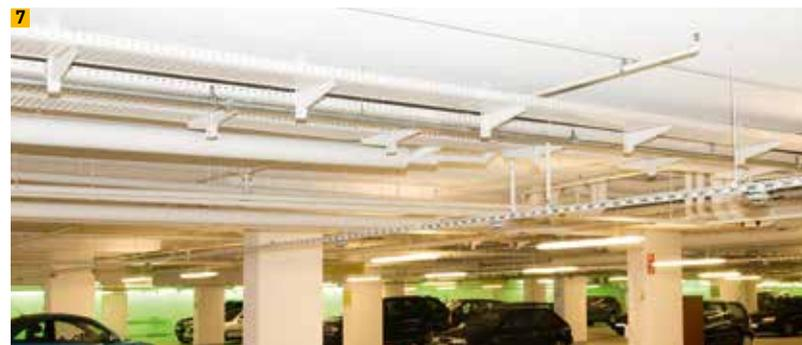
Befestigung einer Sprinkleranlage
