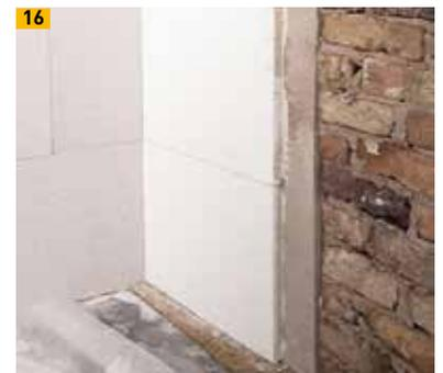
Einbindende Wand mit dem Multipor Dämmkeil
