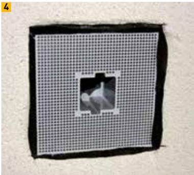
Eingebauter Multipor Teleskop Geräteträger
