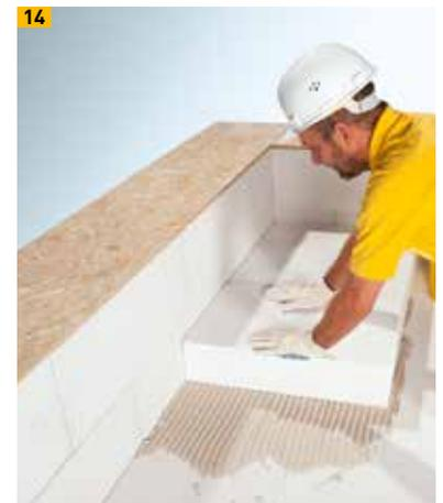
Dämmplattenverlegung in Multipor Leichtmörtel
