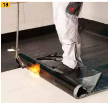
18 Erste Abdichtungslage als thermisch aktivierte Kaltselfstklebebahn
