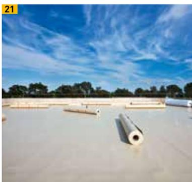
21 Kunststoffdichtungsbahn lose verlegt mit Auflast
