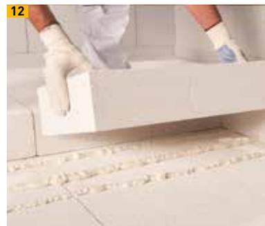
12 Dämmplattenverlegung in PU-Dämmstoffklebeschäum, hier als Montagefixierung
