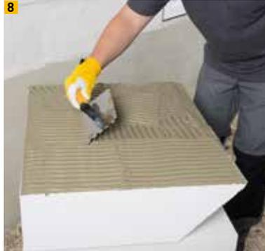
8 Multipor Dichtschlämme mit 10er-Zahntraufel vollflächig auftragen
