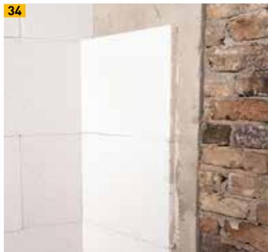
Einbindende Innenwand, mit Dämmkeil gedämmt
