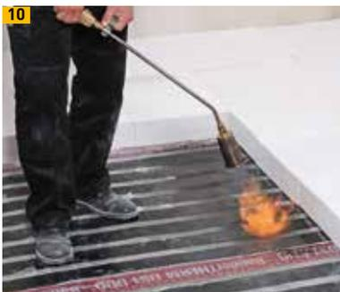
10 Dämmplattenverlegung auf oberseitig thermisch aktivierbare Dampfsperre
