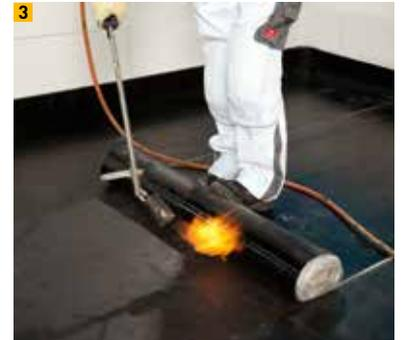
Dampfsperre mit Aluminiumeinlage als Schweißbahn
