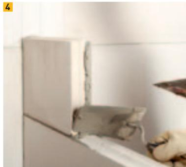
Stoßfugenvermörtelung mittels Silka Secure Dünnbettmörtel
