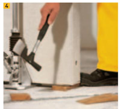
4 Fixieren und Ausrichten mittels Holzkeilen
