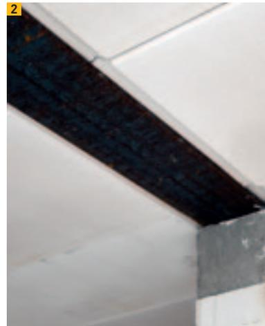
Unterseitig sichtbarer Stahlträger, Ytong Dachelemente passgenau ausgefräst
