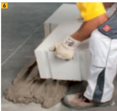
Setzen des ersten Steins an den ausgerichteten Eckstein
