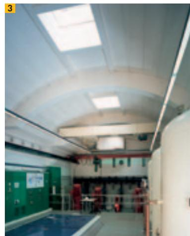
Tonnendach im Industriebau mit Dispersionsanstrich
