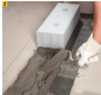
Sperrschicht mit Bitumenabdichtungsbahn
