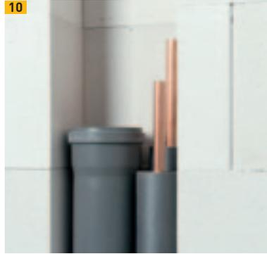
Aussparung für Abfluss- & Heizungsleitungen
