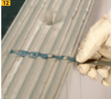
12 Anwendung von Mauerverbindern bei Stumpfstoßtechnik
