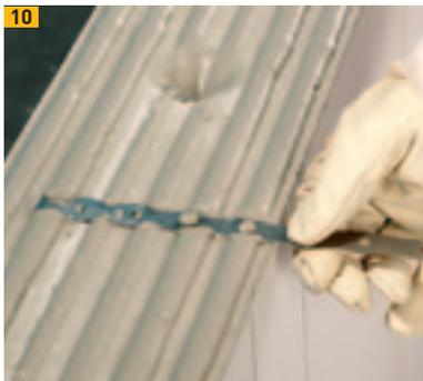
10 Anwendung von Mauerverbindern bei Stumpfstoßtechnik
