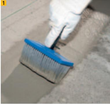
1 Sperrschicht mit Dichteschlämmen
