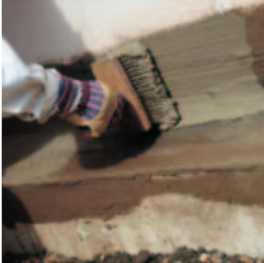
Auftragen einer Dichtschlämme
