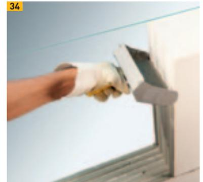
Einfache und vollflächige Stoßfugenvermörtelung
