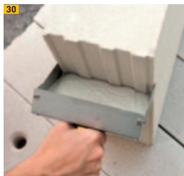
Stoßfugenauftrag Silka Secure Dünnbettmörtel
