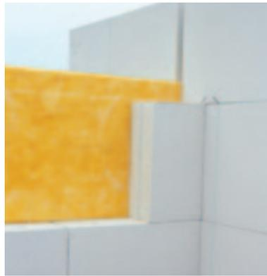
Lösung ausgezeichnet. Dank ihrer hohen Rohdichten erfüllen insbesondere Haustrennwände aus Silka Kalksandstein diese Anforderungen. Guten Schutz bieten bereits zwei 15 cm dicke Schalen aus Silka Kalksandstein mit der Rohdichteklasse 1,8 und einer Fuge von 4 cm – gefüllt mit Mineralfaserplatten des Typs WTH nach DIN V 4108-10. Darüber liegende Rohdichten verbessern den Schallschutz zusätzlich, da das bewertete Flächengewicht der Wand entsprechend zunimmt.
