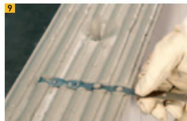
9 Anwendung von Mauerverbindern bei Stumpfstoßtechnik
