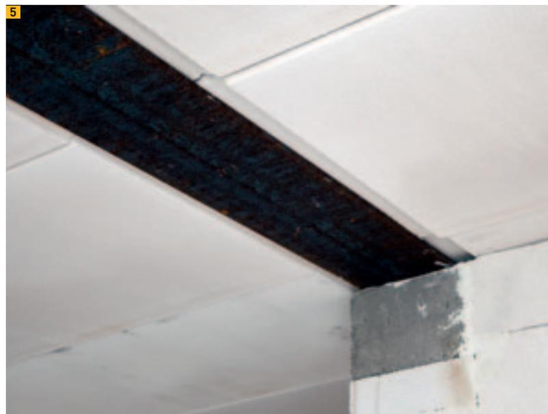
Unterseitig sichtbarer Stahlträger, Ytong Deckenelemente passgenau ausgefräst
