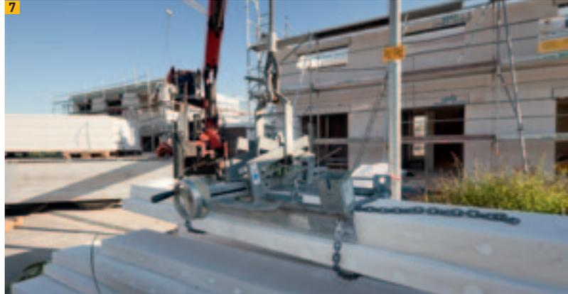
Transportsicherung durch eingehängte Sicherungsketten
