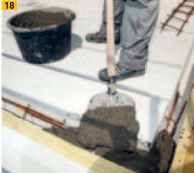
Betoneinbau am Ringanker
