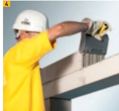
Stoßfugenvermortelung in der Übermauerung
