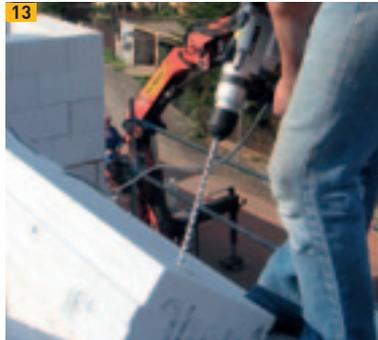
13 Vorbohren für Montagesicherung
