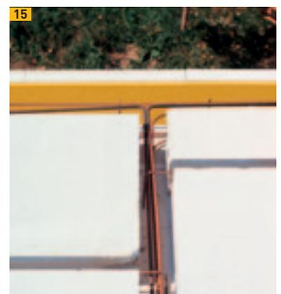
Einbau Ringanker- und Fugenbewehrung
