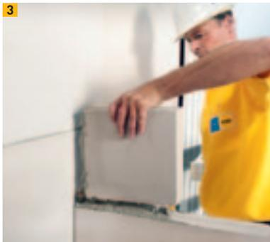
Auftrag Silka Secure Dünnbettmörtel für Stumpfstoß und Setzen des Steins
