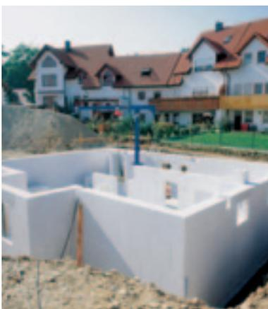
Kellermauerwerk aus Ytong Porenbeton
