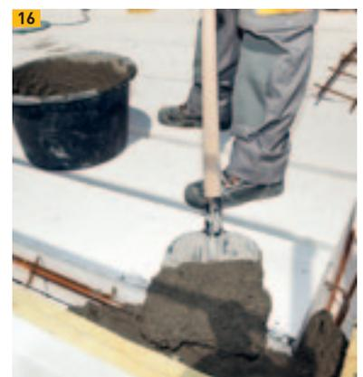
Betoneinbau am Ringanker
