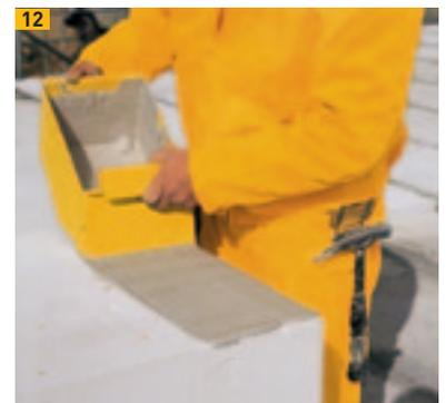
Vermörteln mit Ytong fix P Dünnbettmörtel
