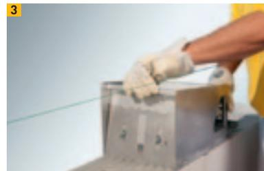
3 Mörtelauftrag auf die Lagerfuge mit Mörtelschlitten und Torbogenverzahnung
