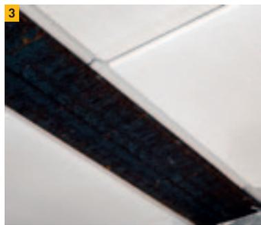
Unterseitig sichtbarer Stahlträger, Ytong Deckenelemente passgenau ausgefräst
