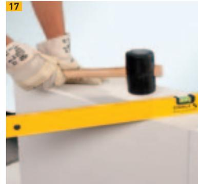
17 Überprüfen und Ausrichten mit Wasserwaage und Gummihammer
