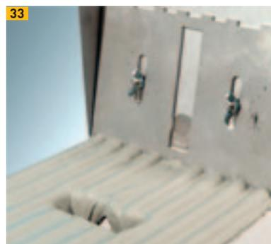
33 Mörtelauftrag auf die Lagerfuge mit Mörtelschlitten und Torbogenverzahnung
