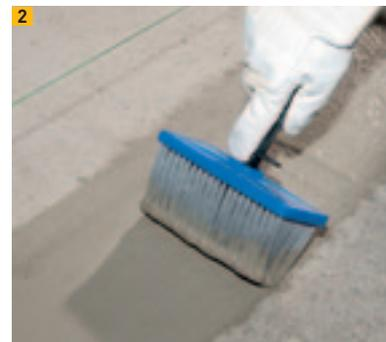
Sperrschicht mit Dichtschlämme
