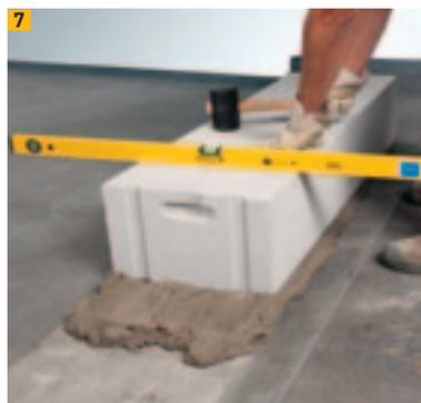
Ausrichten mit Wasserwaage und Gummihammer
