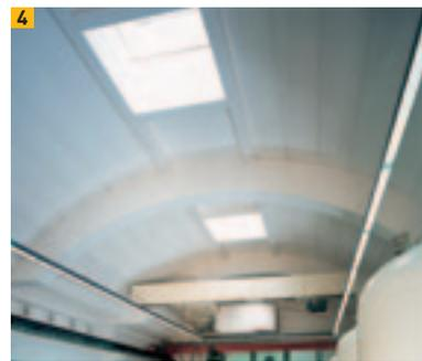
Tonnendach im Industriebau mit Dispersionsanstrich
