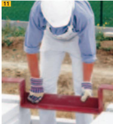
Einbau eines Stahlwechselfers
