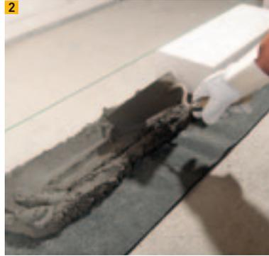
2 Sperrschicht mit Bitumenabdichtungsbahn
