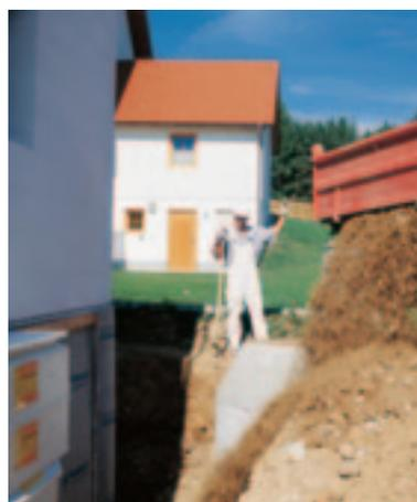
Lagenweises Verfüllen der Baugrube
