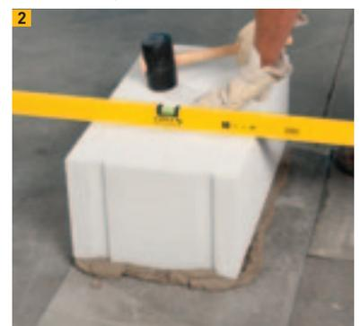
2 Ausrichten mit Wasserwaage und Gummihammer
