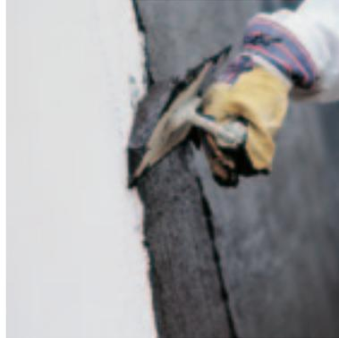
Abdichtung mit einer Bitumendickbeschichtung
