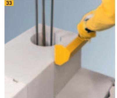
33 Stoßfugenvermörtelung im Eckbereich
