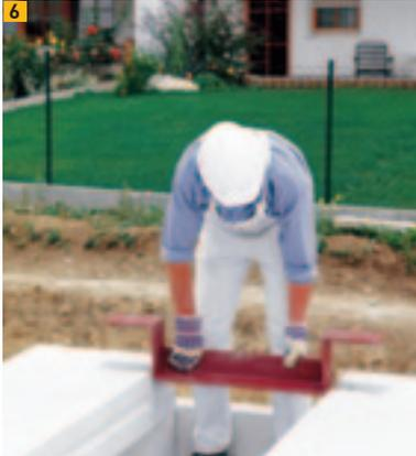
6 Montage Stahlwechsel
