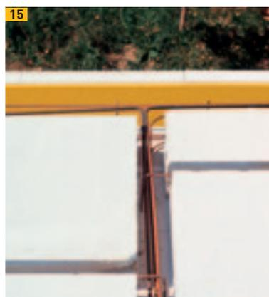
Einbau Ringanker- und Fugenbewehrung
