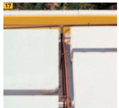
17 Einbau Ringanker- und Fugenbewehrung
