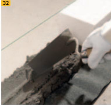
Sperrschicht mit Bitumenabdichtungsbahn
