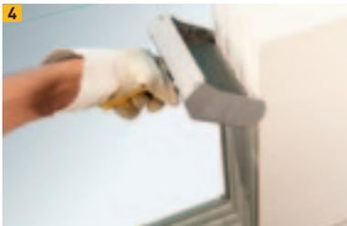
4 Mörtelauftrag auf die Stoßfuge mit Plankelle und Torbogenverzahnung
