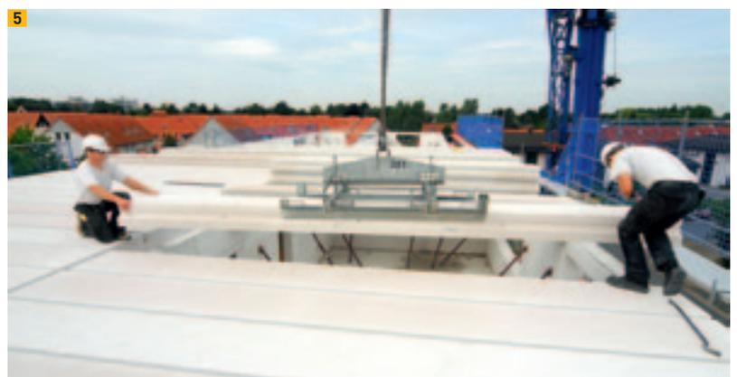
Verlegung von Ytong Dachelementen als Flachdach
