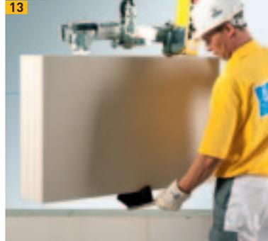
13 Abfeilen der Steinunterseite von losem Material
