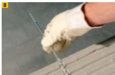
8 Luftschichtanker zum Einlegen
