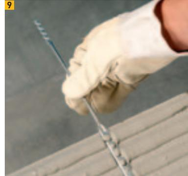
9 Luftschichtanker zum Einlegen
