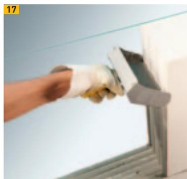
17 Einfache und vollflächige Stoßfugenvermörtelung
