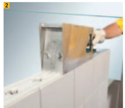
Auftrag von Silka Secure White Dünnbettmörtel auf die Lagerfuge mit Mörtelschlitten und Torbogenverzahnung
