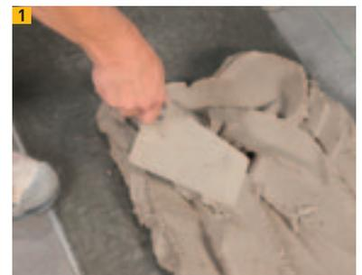
1 Auftragen der ersten Normalmörtelschicht auf die Bodenplatte
