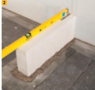
2 Lotrechte Ausführung mittels Wasserwaage
