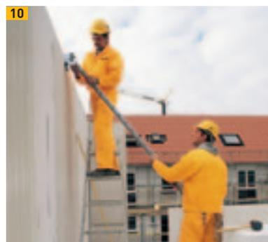
10 Sichern des Ytong Systemwandelements mit Montagstütze
