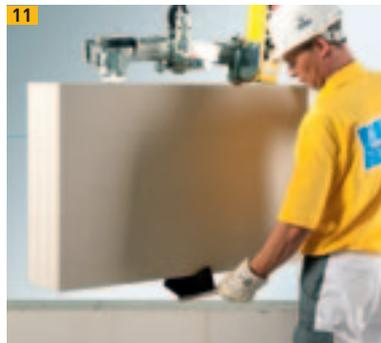
11 Abfeigen der Steinunterseite von losem Material
