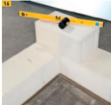
16 Setzen des Ecksteins in der zweiten Schicht
