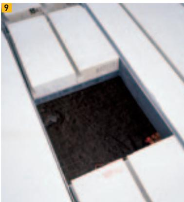
9 Deckenöffnung mit Wechselrahmen
