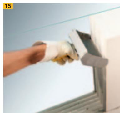
15 Einfache und vollflächige Stoßfugenvermörtelung
