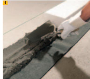
Sperrschicht mit Bitumenabdichtungsbahn
