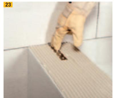
Einlegen des Mauerverbinders in die anschließende Wand
