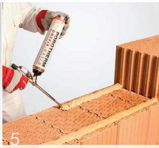
5 Lagerfuge von Staub befreien und gut befeuchten. Auf die wie in Punkt 3 hergestellte erste Ziegelschar werden nun parallel 2 Kleberstränge mit ca. 3 cm Breite aufgetragen. Bei Wandstärke 10 und 12 cm wird nur 1 Kleberstrang mittig aufgetragen.
