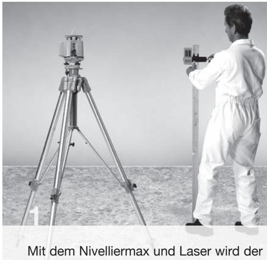
1 Mit dem Nivelliermax und Laser wird der höchste Punkt auf der Rohdecke ermittelt und in Wandbreite eine Bitumenbahn aufgelegt.
