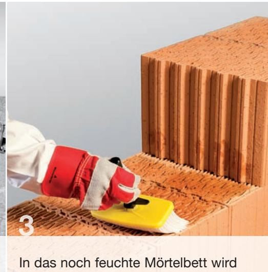
3 In das noch feuchte Mörtelbett wird die erste Ziegelschar versetzt und ausgerichtet. Das exakte Einrichten der ersten Ziegelschar auf Ebenflächigkeit ist mit größter Sorgfalt durchzuführen und durch Auflegen einer 3-4 m langen Alulatte zu überprüfen und ggf. zu korrigieren.
