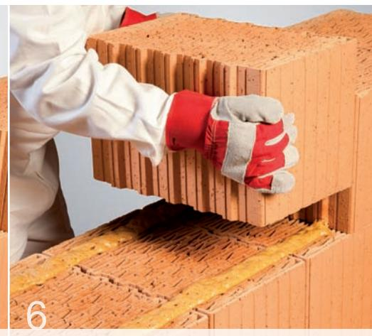
6 Den Planziegel innerhalb 3 Min. aufsetzen und bereits aufgesetzte Planziegel nicht mehr wegheben. Nach Gebrauch die Pistole mit Schaum gefüllt lassen. Immer eine gefüllte Dose auf der Pistole lassen. Dose immer aufrecht wegstellen.
