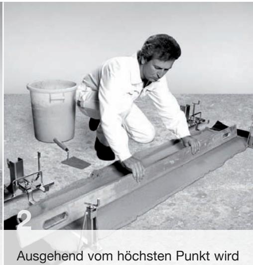
2 Ausgehend vom höchsten Punkt wird ein ca. 1,5 cm dickes vollflächiges Mörtelbett für die erste Ziegelschar angelegt. Der Nivelliermax ermöglicht ein millimetergenaues Abziehen des Mörtelbettes mit der Messlatte.
