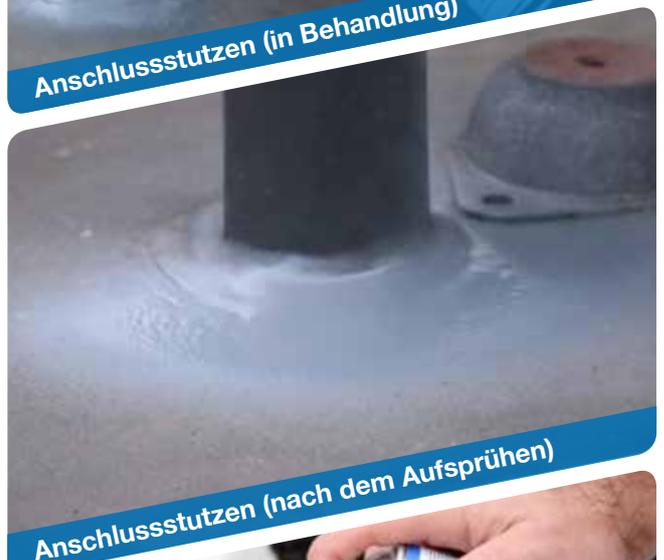
Anschlussstutzen (nach dem Aufsprühen)
