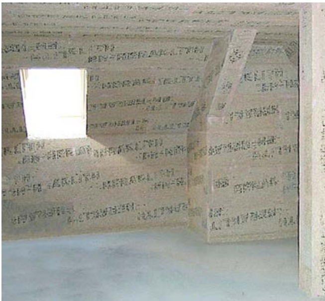
Dachkonstruktion beplankt mit Heraklith BM-Platten
