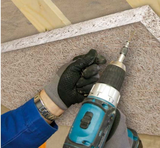
Befestigung der Heraklith BM-Platte (35 oder 50 mm) mit Heraklith Kompaktbauschrauben, Länge 60 bzw. 80 mm.
