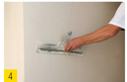
4 best wood Armierungsgewebe eingespachtelt.
