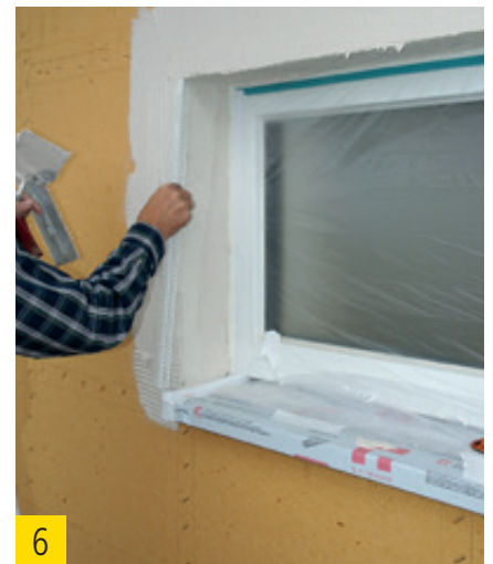
6 Gewebeeckwinkel einsetzen.
