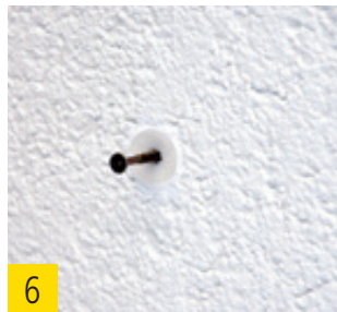
6 Mit 4–5 mm Schraube Anbauteil befestigen.
