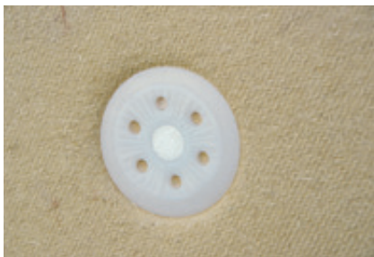
Dämmstoffschraubdübel plan mit best wood WALL 140/180 montiert.
