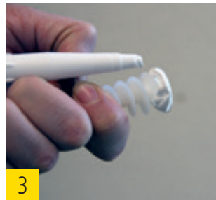
3 best wood Fugen-Klebedichtmasse FDM zur Abdichtung verwenden.
