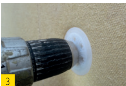
Dübel oberflächenbündig anziehen.
