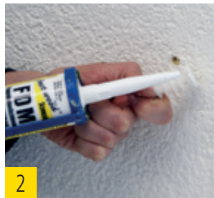
2 best wood Fugen-Klebedichtmasse FDM unter Dübelteller auftragen.
