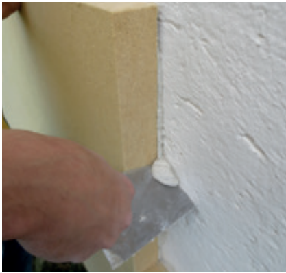
Seitlich austretendem Kleber entfernen.
