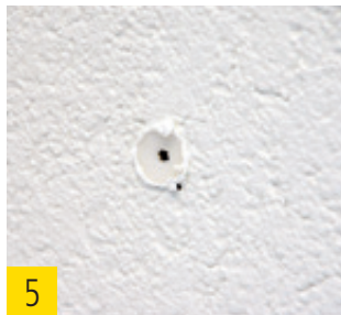
5 Überschüssiger FDM zwischen Putz und Spiraldübel entfernen.
