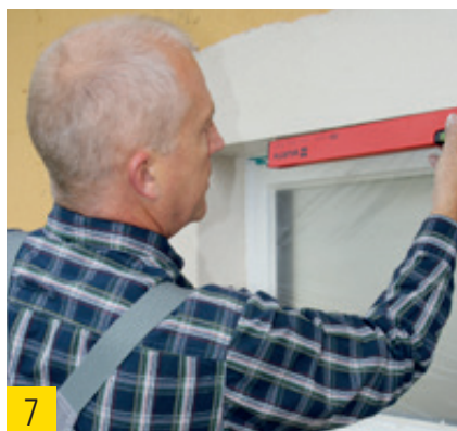
7 Gewebeeckwinkel horizontal und vertikal ausrichten.
