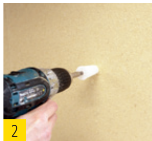
2 Spiraldübel mit TORX T40 in unverputzter Holzfaser-Dämmstoffplatte eindrehen.
