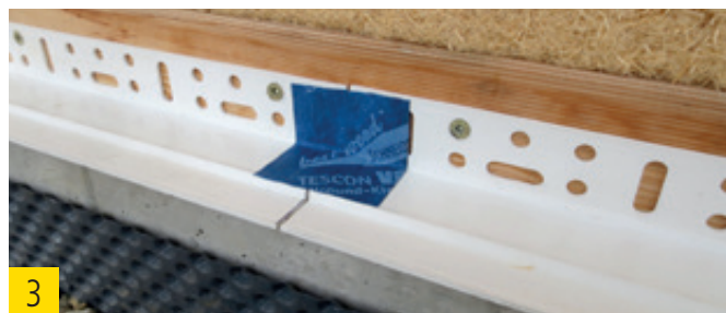
3 Stoß mit Gewebeklebeband abkleben.
