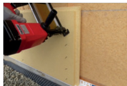
Befestigung mit Breitrückenkammern.
