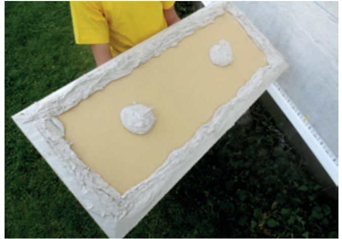
Auftrag Punkt-Wulst-Verfahren.
