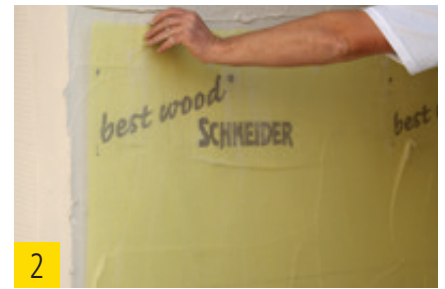
2 best wood Armierungsgewebe einlegen.
