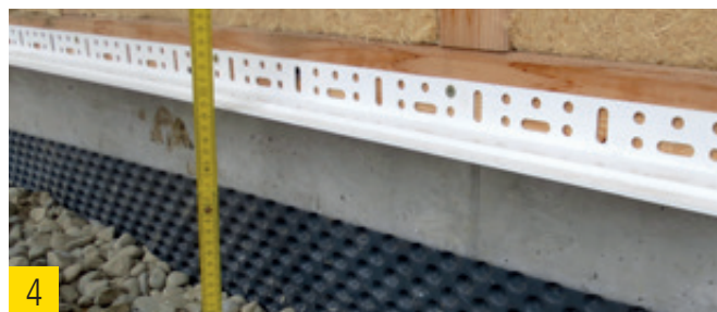
4 Spritzwasserzone \geq 30 cm ohne zusätzliche Maßnahme.
