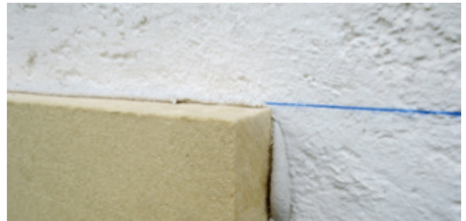
WALL 140 an waagerechter Schlagschnur ausrichten.
