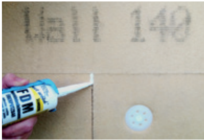
Verlegefugen mit FDM schließen.
