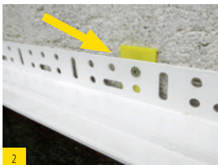
2 Distanzausgleich an Sockelschiene.
