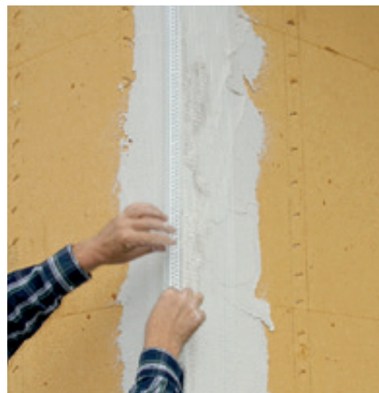
Gewebeeckwinkel einsetzen.
