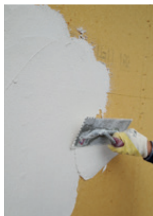
Klebe- und Armierungsmörtel (UP) aufbringen.
