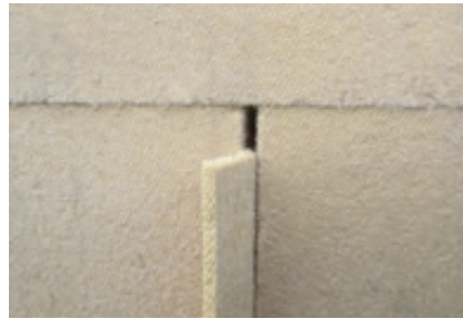
Verlegefugen mit Streifen aus best wood WALL 140/180 schließen.
