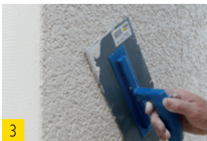
Oberputz mit Traufel strukturieren.
