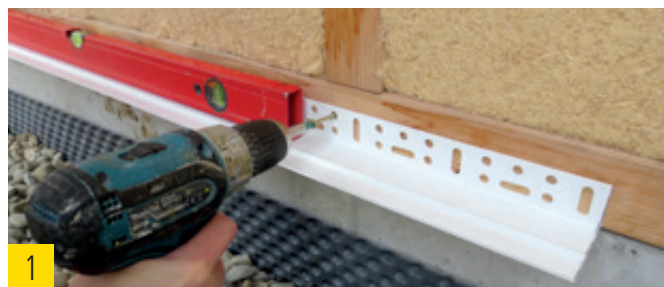
1 Sockelprofil waagrecht ausrichten und befestigen.
