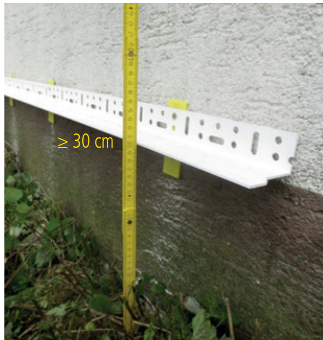
Spritzwasserzone \geq 30 cm ohne zusätzliche Maßnahme.
