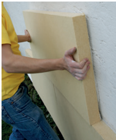
WALL 140 mit schiebenden Bewegungen anbringen.
