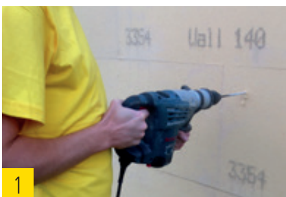
Vorbohren mit Schlagbohrmaschine.
