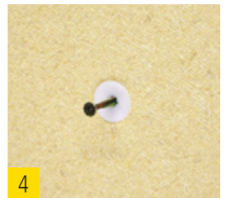
4 Mit 4–5 mm Schraube Anbauteil befestigen.
