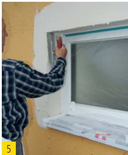
5 Teleskopanputzleiste einspachteln.
