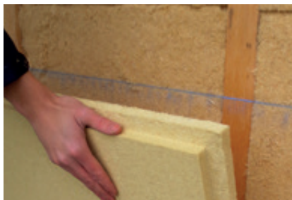
Erste Plattenreihe an waagrechter Schlagschnur ausrichten.
