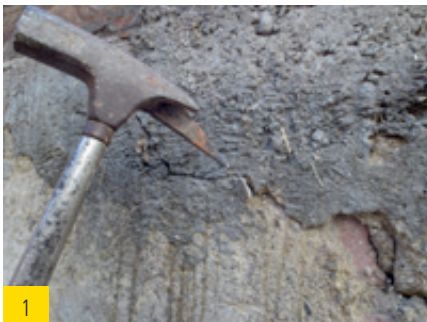
1 Lose Putzschichten entfernen.
