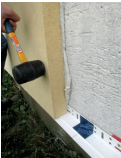
WALL 140 vollflächig auf Sockelschiene aufstellen.
