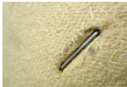
Breitückenklammer ca. 1 mm in der best wood WALL 180 vertieft.
