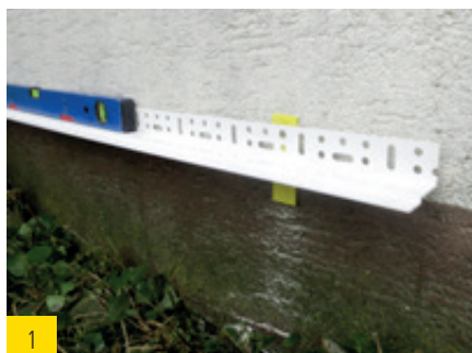
1 Sockelprofil waagrecht ausrichten und befestigen.
