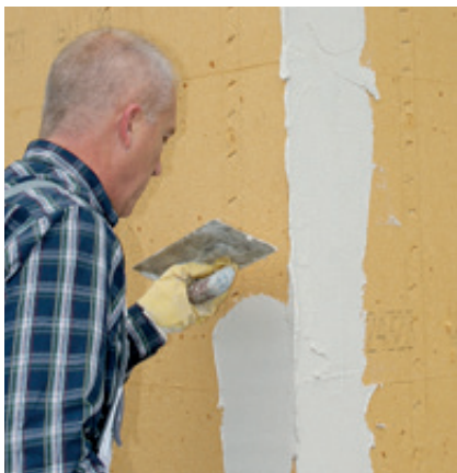
Klebe- und Armierungsmörtel (UP) aufziehen.
