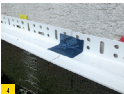
4 Stoß mit Gewebeband abkleben.
