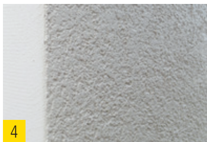
Fertig strukturierte Putzfläche.
