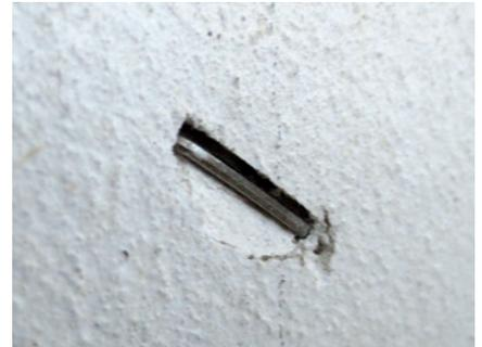
Die Breitrückenklammern sind um die Schichtstärke der Putzschicht vertieft einzubringen.
